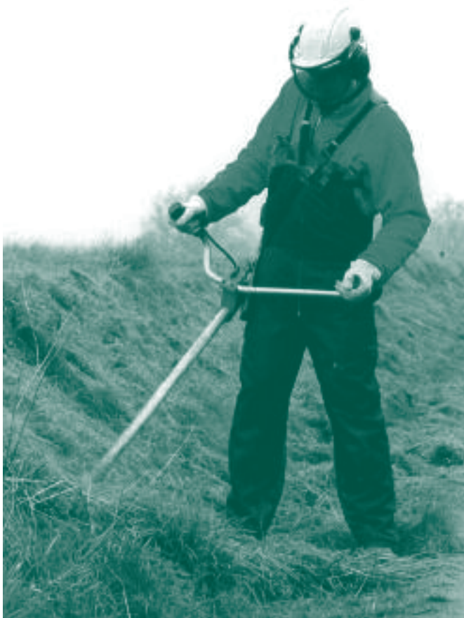
Figuur 4.1 Maaien van talud met juiste beschermingsmiddelen (foto: Landschap Noord-Holland)
