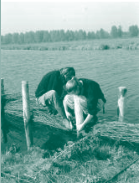
Figuur 3.7 Oeverbeschoeiing (foto: Landschap Noord-Holland)
