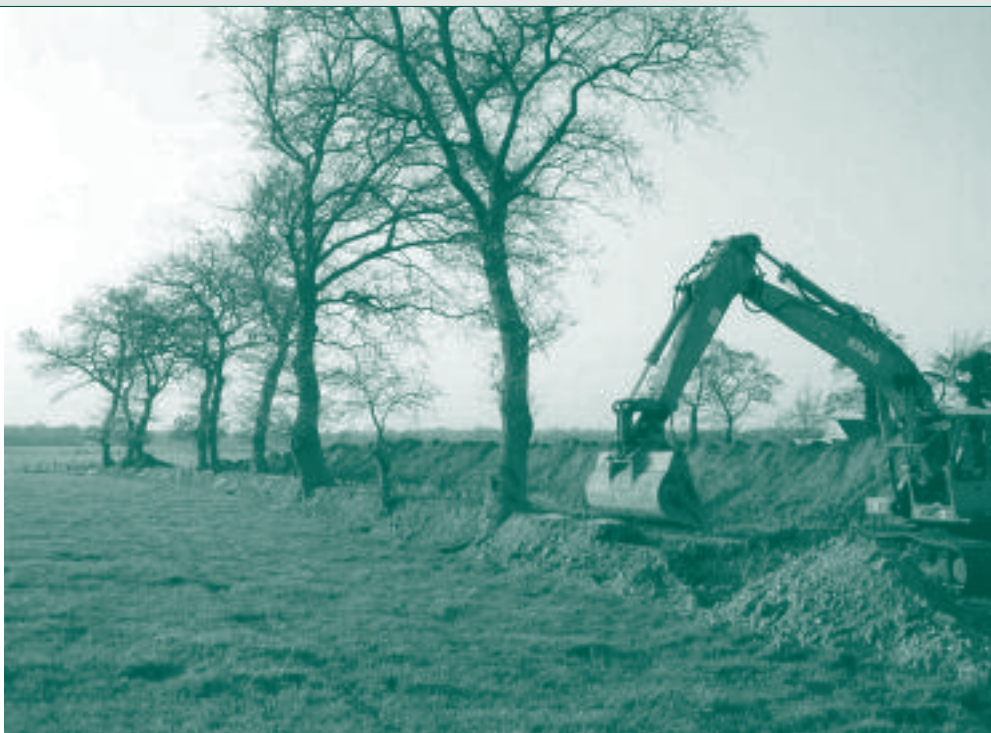
Figuur 1.1 Grondwerk ter herstel van een houtwal (foto: Landschapsbeheer Friesland)
